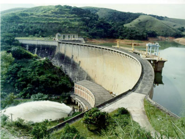
Figura 1. Vista geral da barragem de Funil
